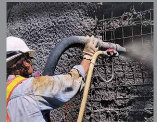
Concreto lanzado
