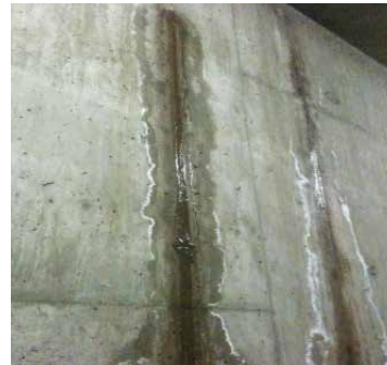
Filtración en juntas
