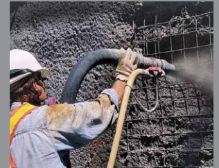
Concreto lanzado
