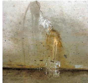
Filtración en juntas
