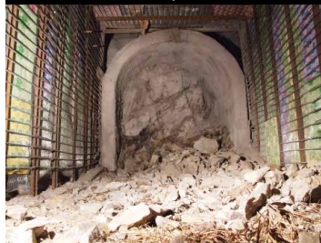
Perforación y Voladura
