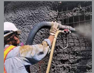
Concreto lanzado
